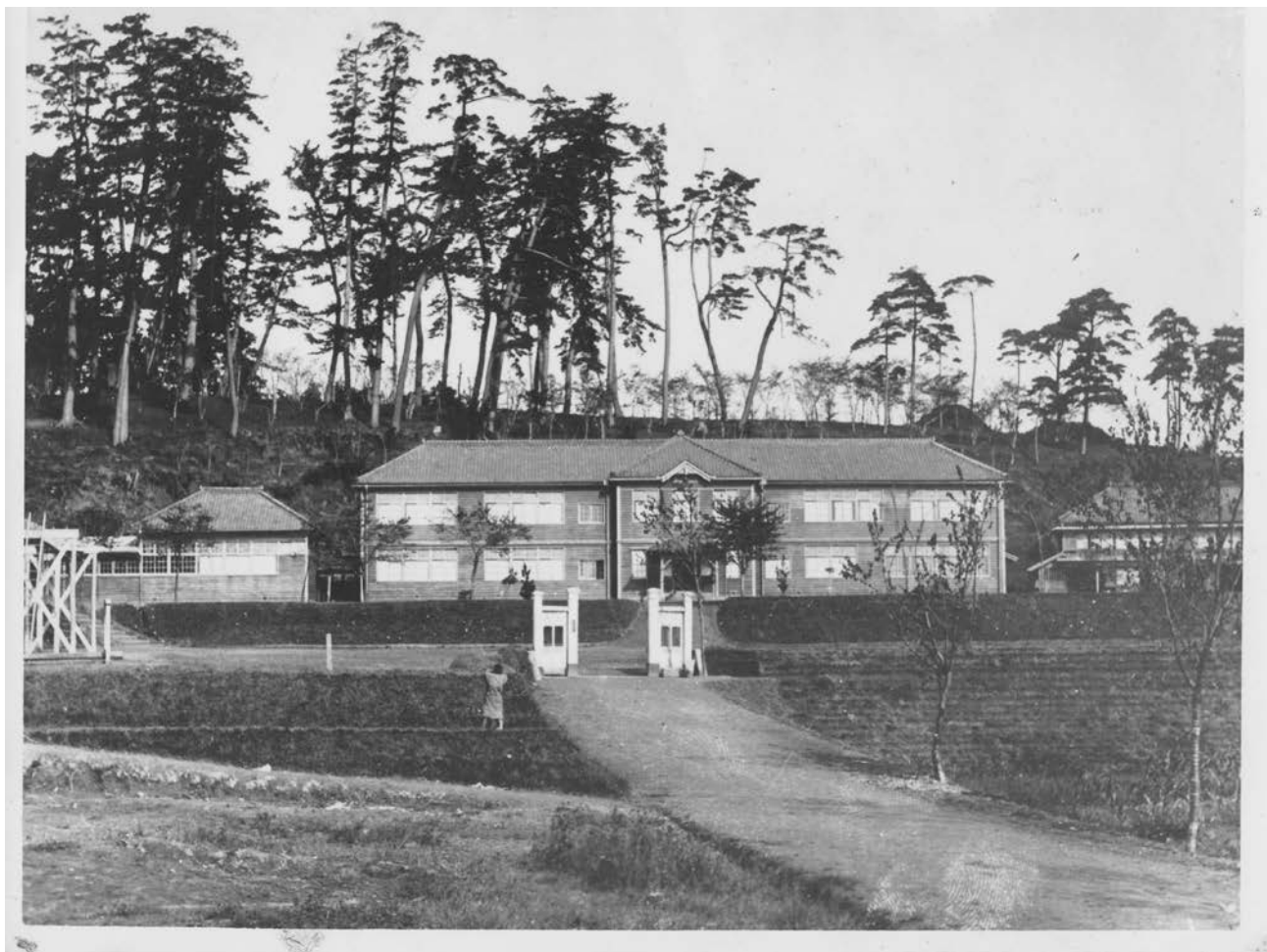
(完成間もないころの校舎。右手に旧塾舎を移築した寄宿舎が、背後には古墳のようなものが見える。)
